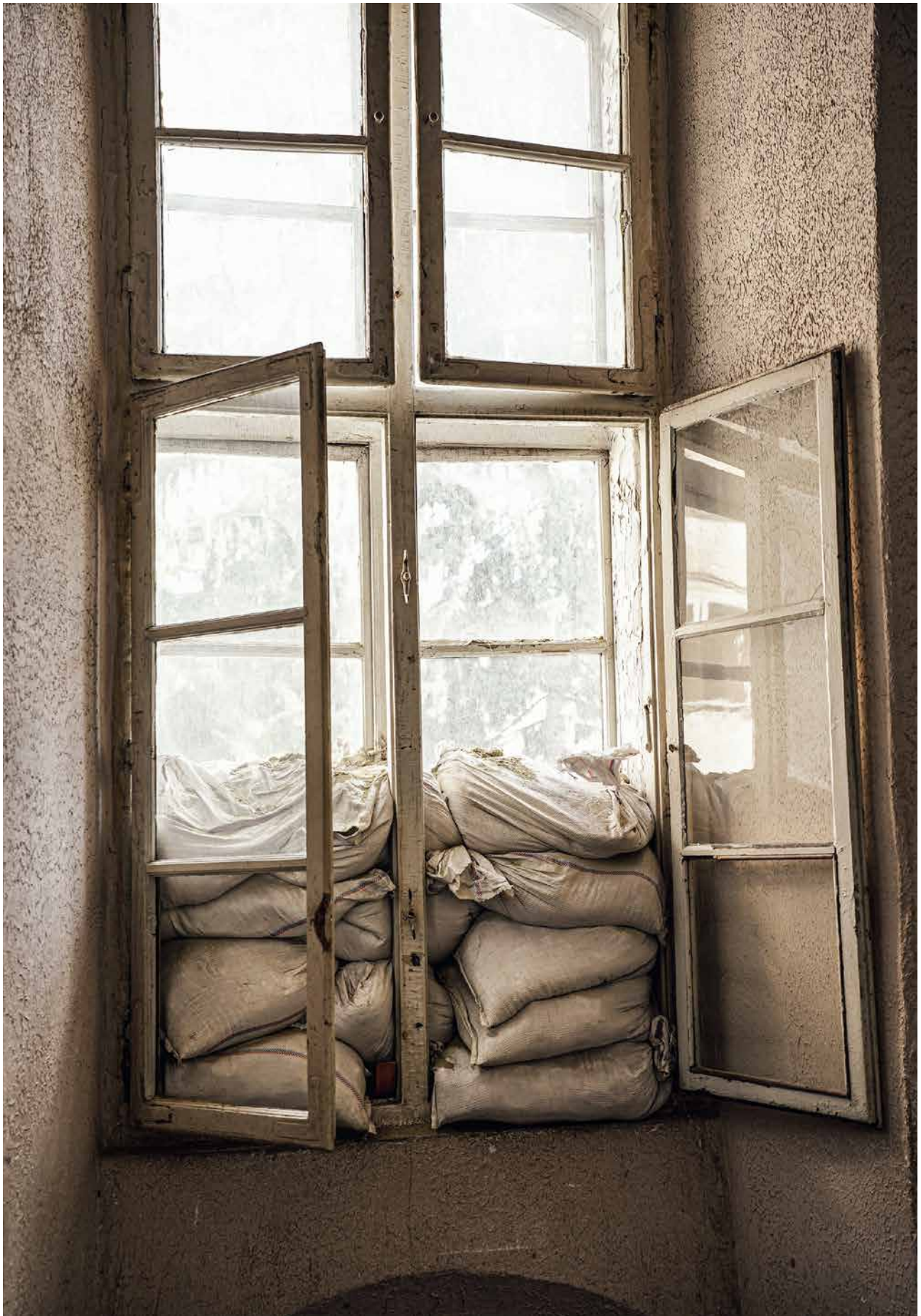
Die einen Fenster in der Wohnung sind zum Schutz mit Sperrholzplatten vernagelt, andere müssen wegen Druckwellen durch Einschläge ständig offen bleiben.
